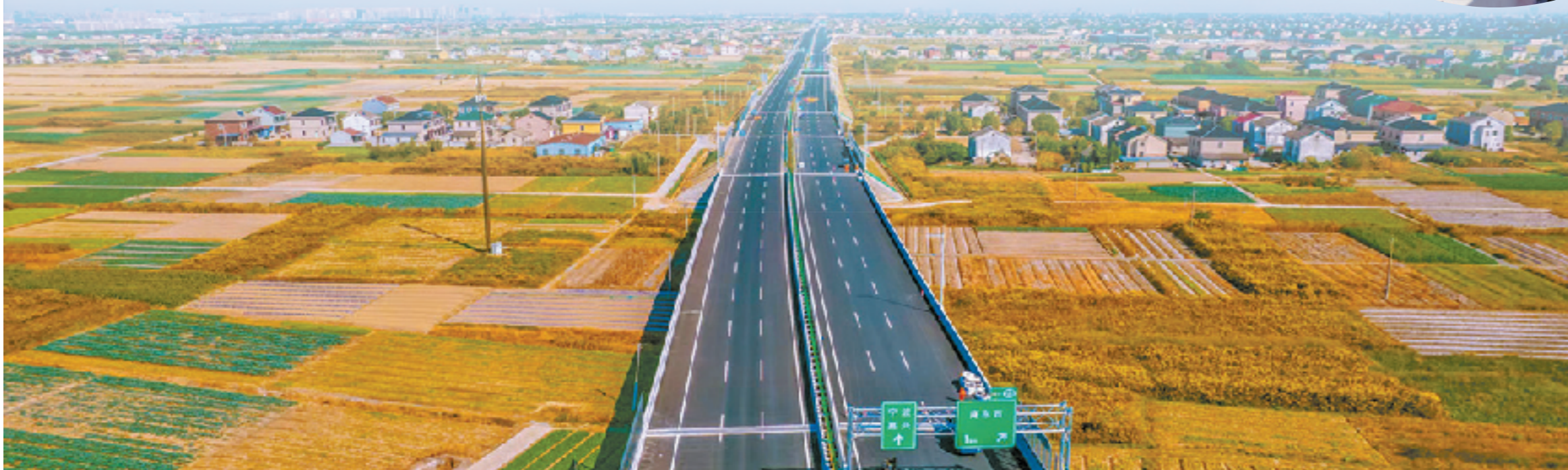
杭甬复线宁波一期项目庵东至双凤路段
