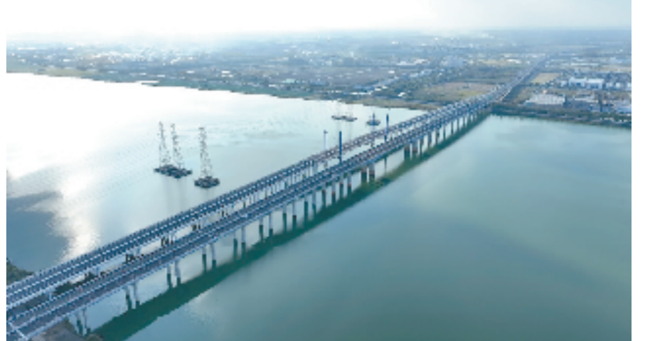
杭绍甬高速杭绍段项目曹娥江特大桥
