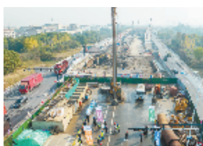
中横线快速路(二期)首桩开工
