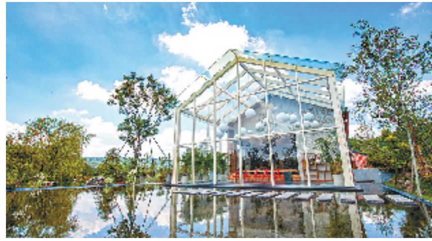
嘉兴海盐澉浦镇北里湖风貌驿
