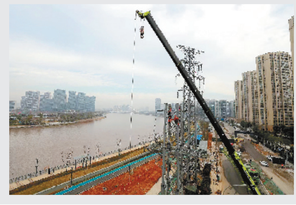
近日，在宁波市鄞州区奉化江畔，20余名电力工作人员实施高空作业，成功拆除了沿岸3基110千伏老旧铁塔。为消除安全隐患，优化国土空间利用，美化城市环境品质，国网宁波供电公司积极推进核心区老旧高空设备拆除工程，助力宁波提升现代化滨海大都市建设品质和发展能级。
