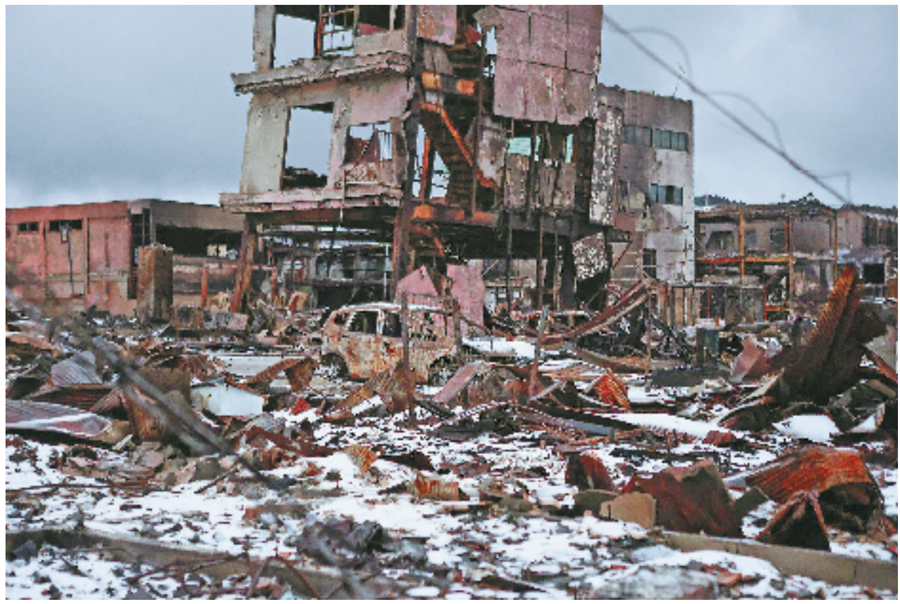
1月7日,在日本石川县轮岛市,降雪覆盖一处倒塌的房屋。
