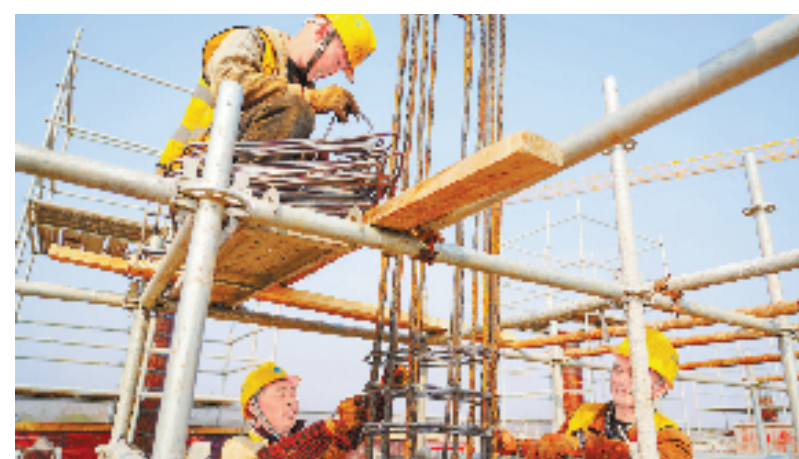
2023年12月31日,在金华市东山区金湖潮科技创新策源地项目现场,为保证工程进度,工人们坚守岗位,紧张有序开展各项工作。
