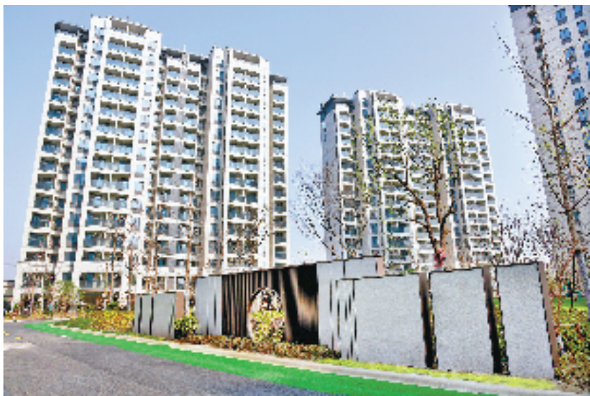
上城区滨河海景轩安置房（杭州市上城区农居建设管理中心供图）
