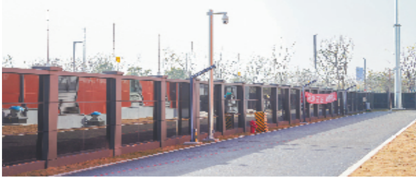
110千伏安吉城北变的光伏一体化围墙和橡胶沥青路面 (图片由国网湖州供电公司提供)
