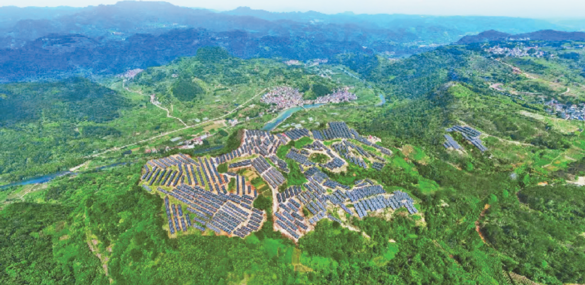
新昌冷水村农村光伏项目 陈琪 摄
