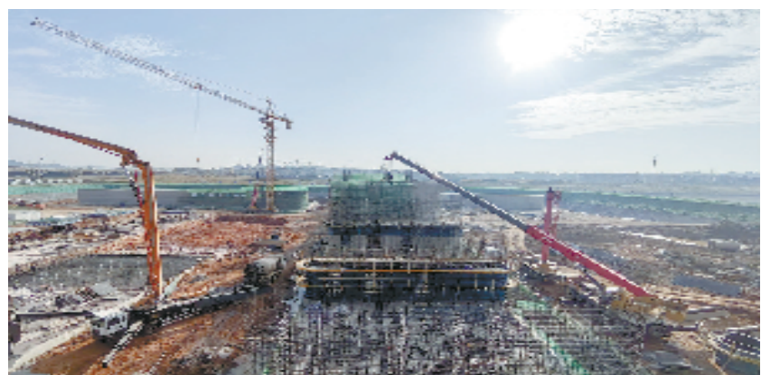
常山江航电枢纽项目柯城段项目施工现场 (图片由衢州市信安航运建设发展有限公司提供)
