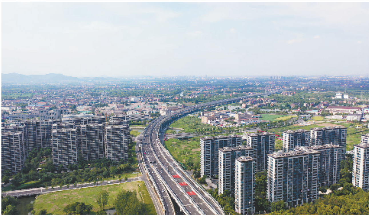
运溪高架 余杭区交通运输局供图
