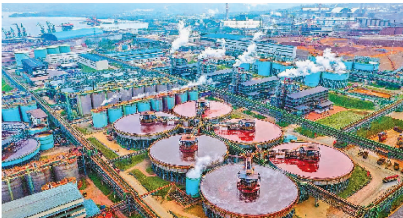
华友印尼华越镍钴年产6万吨项目鸟瞰图(中国民生银行杭州分行供图)
