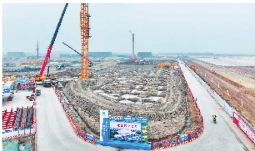
12月11日,在嘉兴机场项目建设现场,道面混凝土完成5.4万方,完成形象进度38.1%,跑道初具雏形。 张启帆 摄
