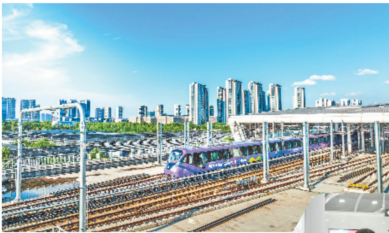
运行中的杭州地铁“亚运号”专列
