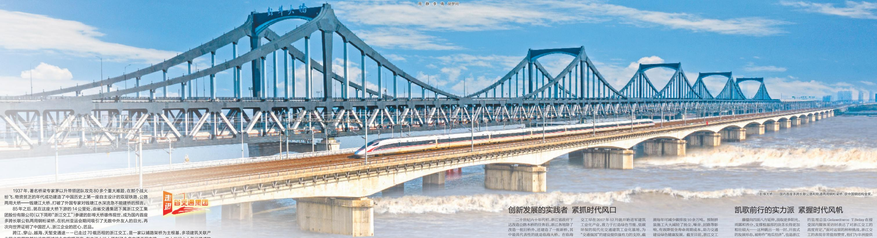
彭埠大桥——国内首座多跨长联公路和轨道两用钢桁梁桥，获中国钢结构金奖。
