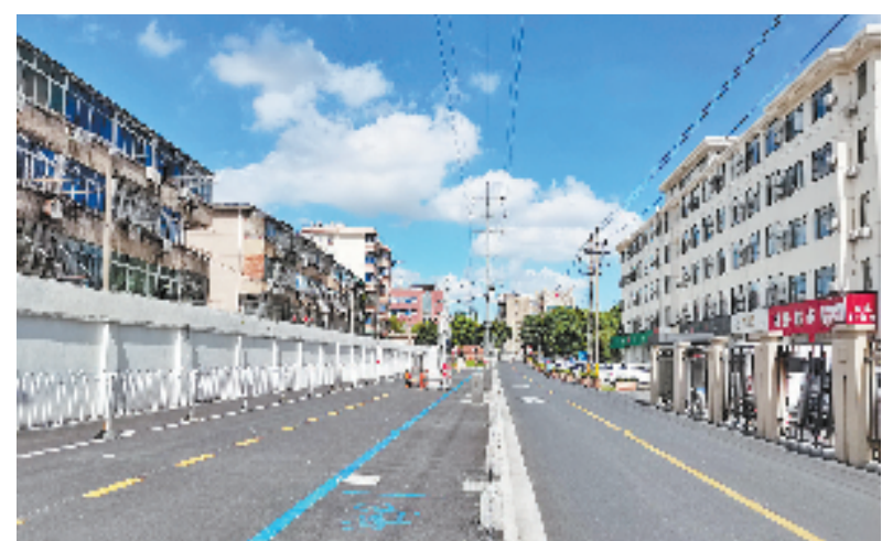
嘉兴市区凯旋路提升改造街段 (图片由嘉兴市综合行政执法局提供)
