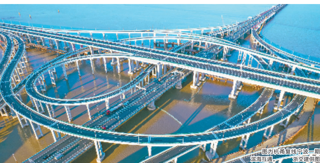
图为杭甬复线宁波一期滨海互通。 浙交建供图
