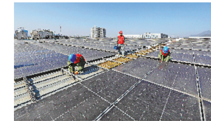
12月7日,国家电网义乌市供电公司专业人员前往义乌市多家大型企业,对其光伏屋顶开展设施、线路、房屋隐患等项目检查,确保安全度过冬季寒冷天气。图为专业人员在义乌市苏溪镇天台光能公司光伏屋顶进行检查。本报记者 钱关键 拍友 时补法 摄
