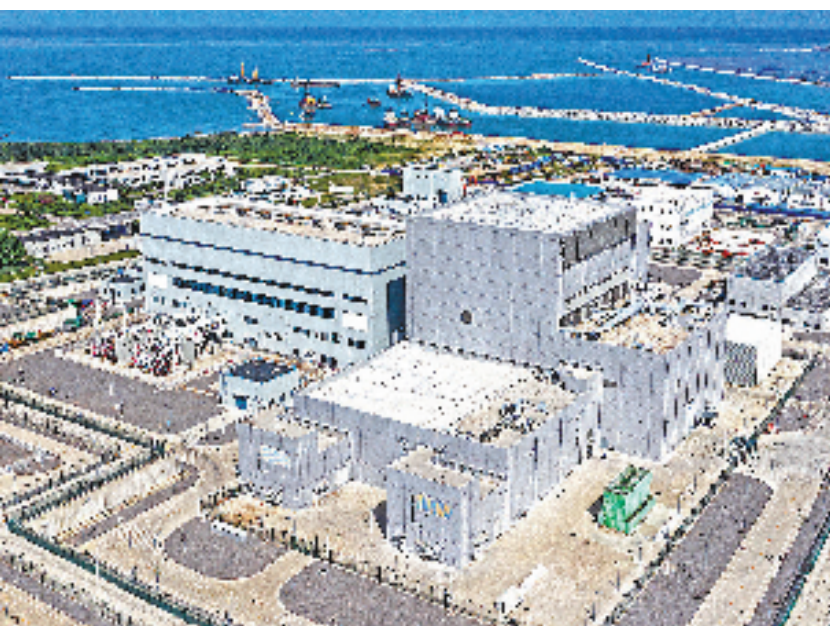
图为华能石岛湾高温气冷堆示范工程外景(资料照片)。
