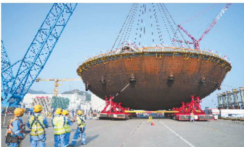
三门核电3号机组底封头吊装 吴岚 摄
