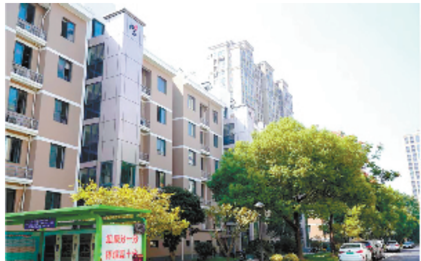
河庄街道钱民花园加装电梯全覆盖 (图片由河庄街道提供)
