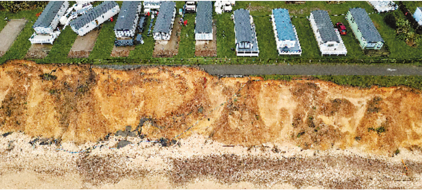
滨海道路 塌陷
