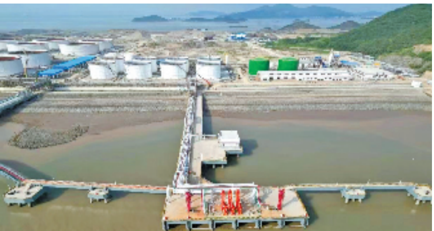
舟山某油品码头现场图
