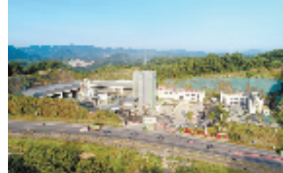
大业公司沥青拌合楼
