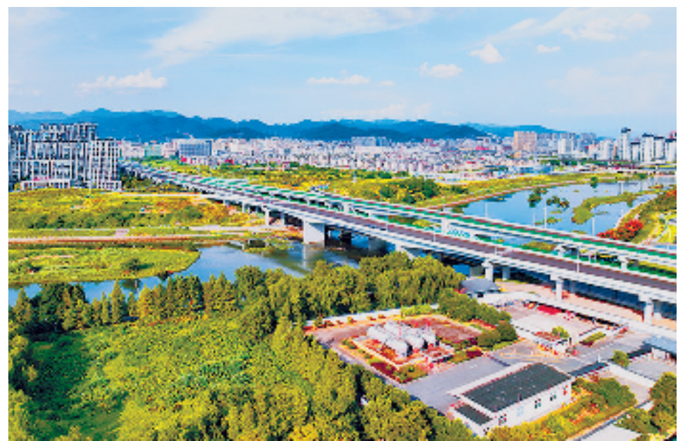
义东高速江北至南市段东阳江大桥
