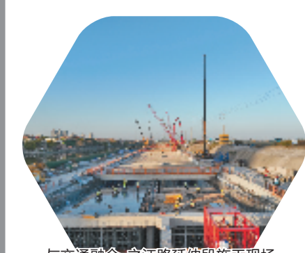
与交通融合,沿江延伸延伸施工现场。
