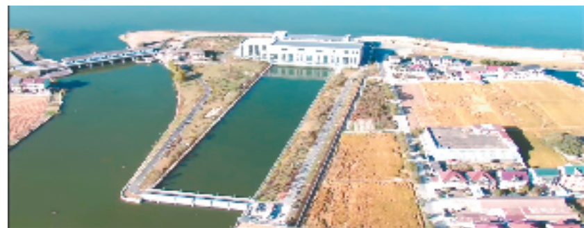
验收完成的马山闸强排及配套河道工程(越城区农业农村和水利局提供)
