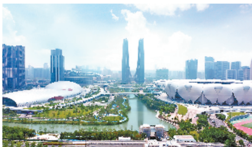
钱江世纪城亚运水系——利民河 杭州林水局供图
