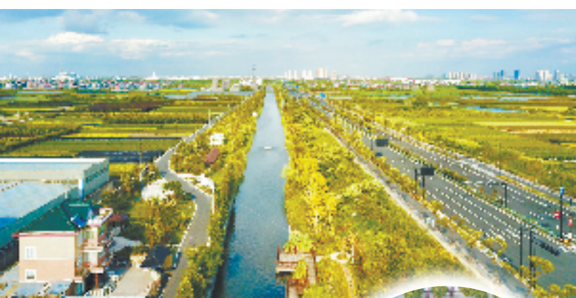
钱塘区江东三路(县道)新建开通
