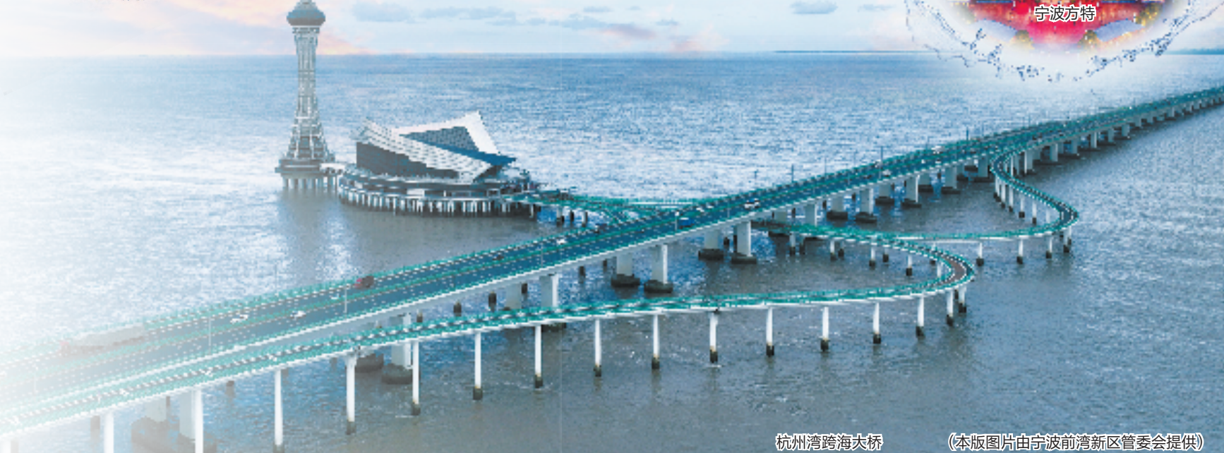
杭州湾跨海大桥
