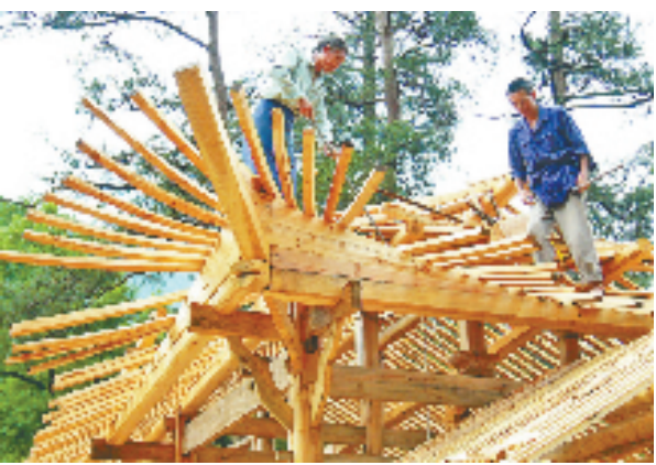
建设中的新廊桥
