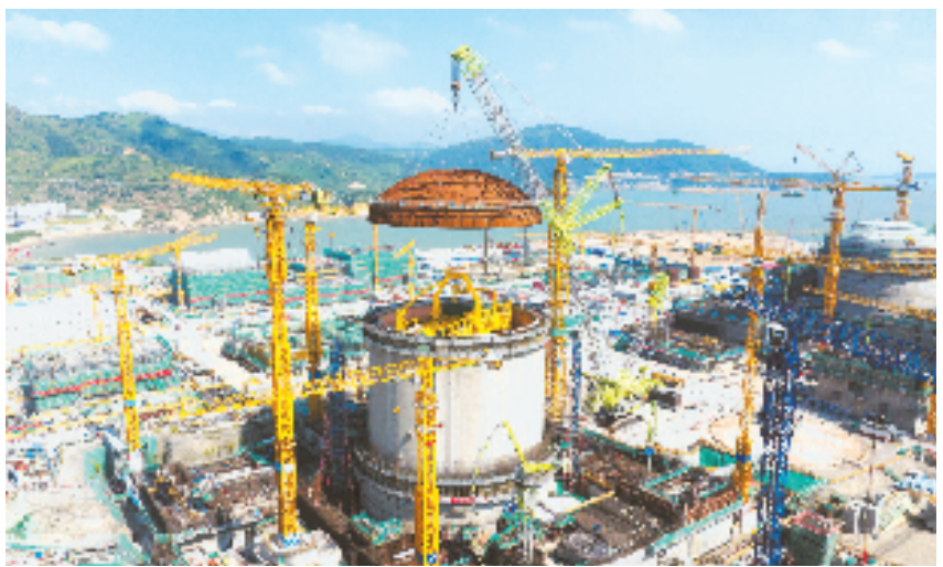
图为浙江三澳核电2号机组吊装穹顶现场。
