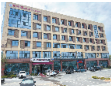
雨灵山村物业大楼
