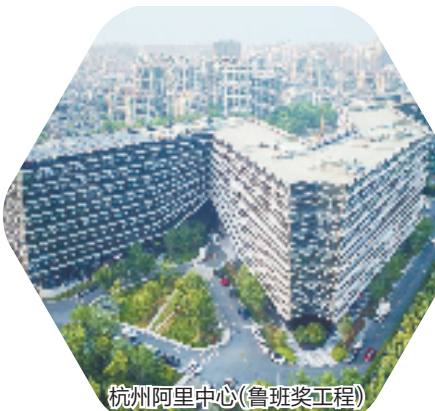
杭州阿里中心(鲁班奖工程)
