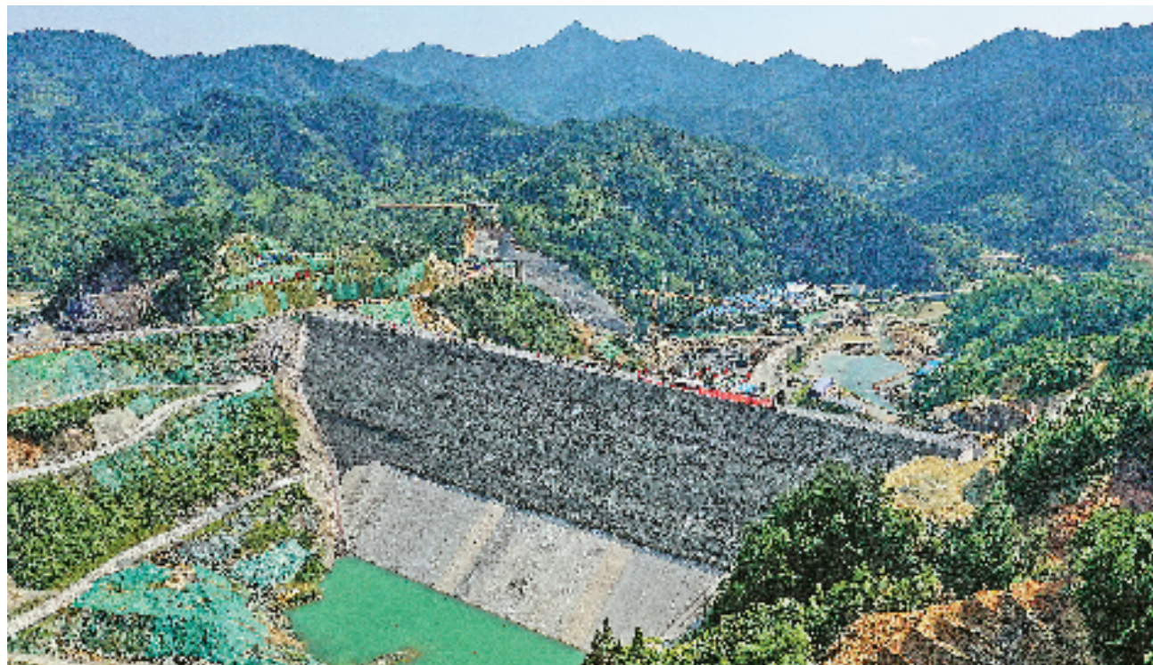
9月19日,在开化县马金镇,开化水库大坝拦河坝填筑到顶。大坝高85.5米,坝顶长度为385米。
