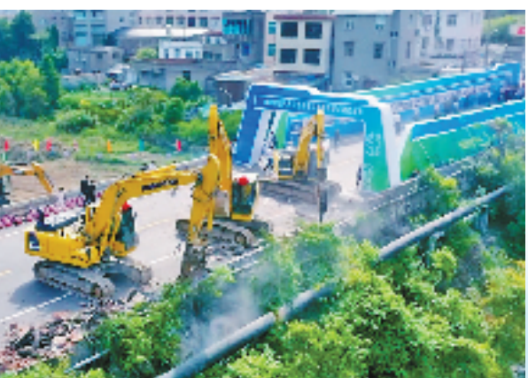
2022年9月,玉环市拆除建成使用45年的漩门大坝,断流45年的漩门湾水系复流,周边海洋生物的栖息环境不断改善。
