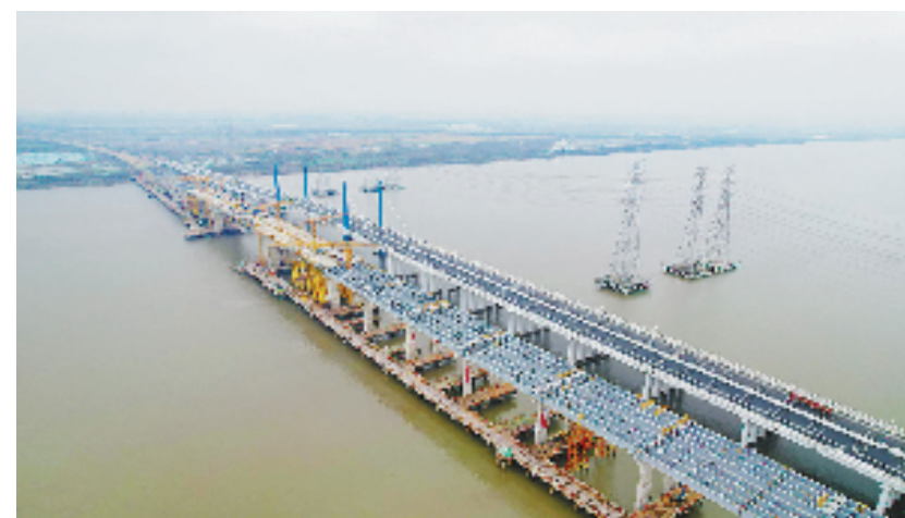
曹娥江特大桥钢梁架设顺利完成，全桥贯通。
