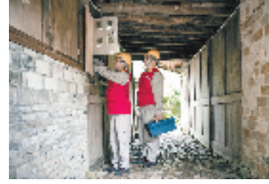
黄岩供电“乡村振兴”小队对古村落开展巡线与隐患排查
