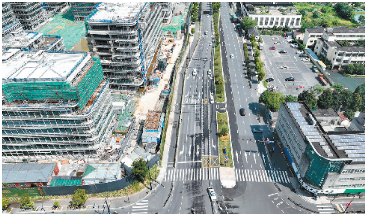
治理后的五常大道荆长路路口 (图片由余杭区交通运输局提供)
