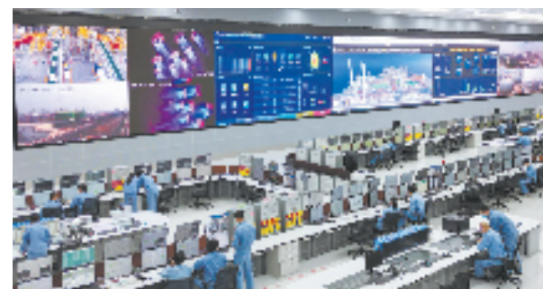
镇海基地一期中央控制室
