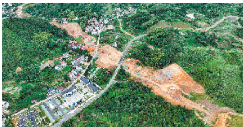
104国道新昌庄前至关岭段改建工程
