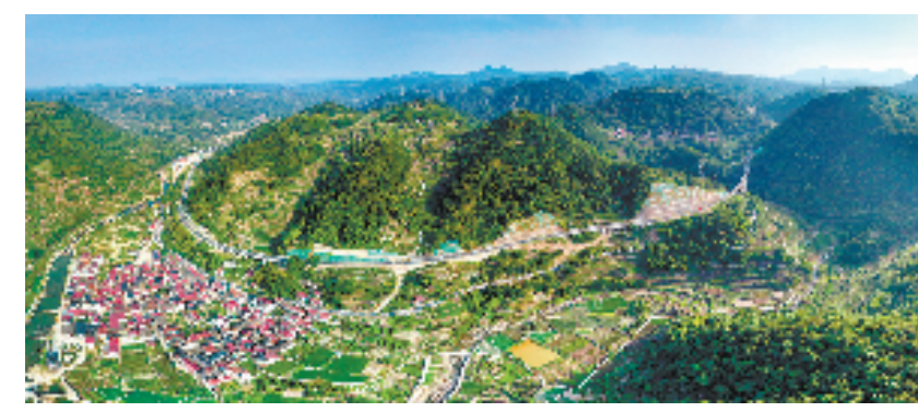
太下线改建工程
