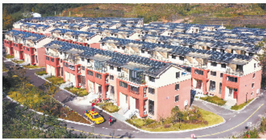
国网宁波供电公司海曙区推进整村屋顶光伏。 王幕宾 摄
