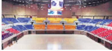
绍兴市奥体中心体育馆采用的“双层龙骨加弹性胶垫的悬浮式专业运动地板”，不仅触感良好，还拥有良好的减震效果，可满足不同球类比赛的使用要求。双层龙骨加弹性胶垫的设计，可将作用力有效分解到不同单元，实现对震动(冲击力)的梯度吸收和吸收量的可调整性。
