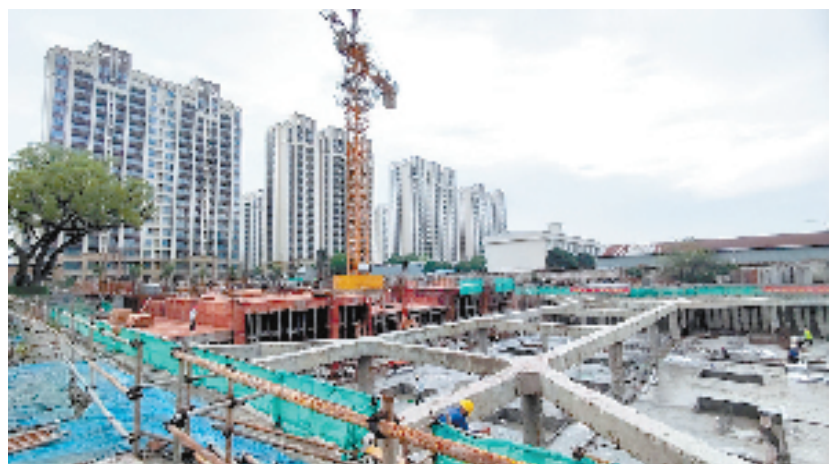
北城街道社区卫生服务中心(永宁医院)迁建工程进入主体施工阶段
