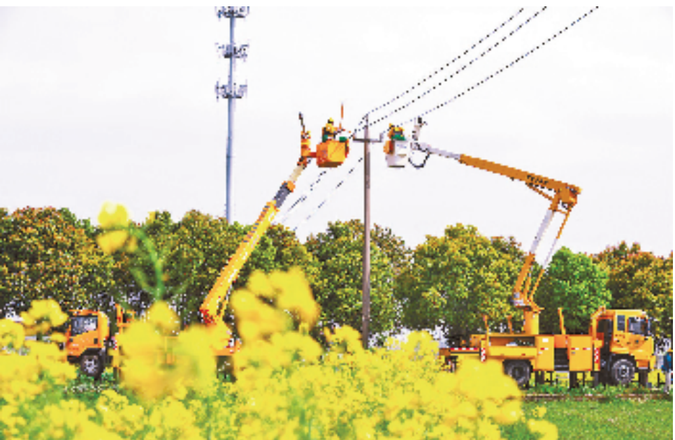
带电作业班开展配网不停电作业
