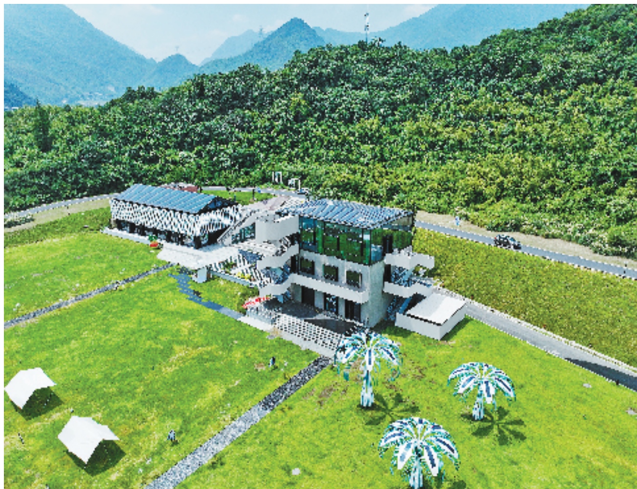
图为余村未来图书馆,该建筑主要通过铺设在屋顶上的光伏发电系统和“光伏树”供电(无人飞机照片)。
