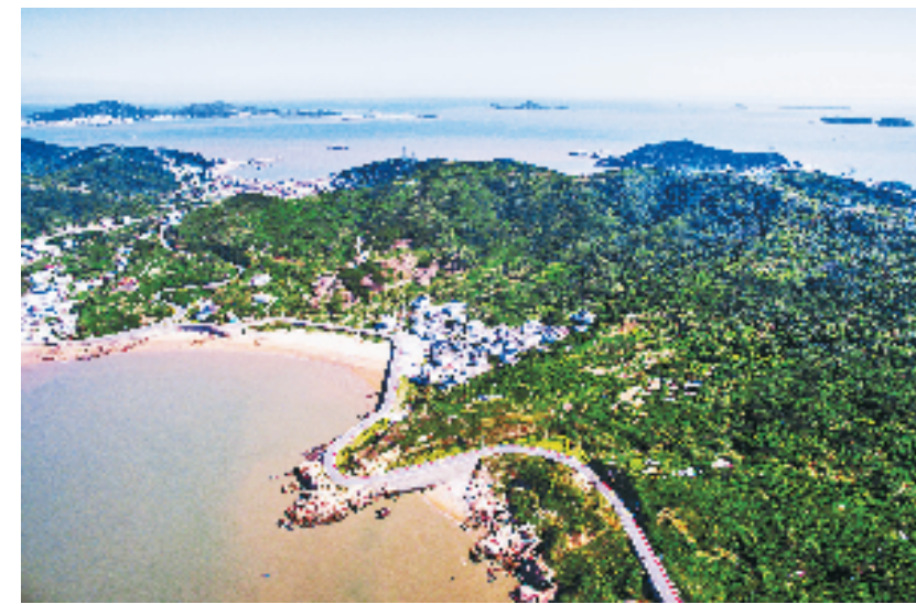
嵊泗县左岸公路
