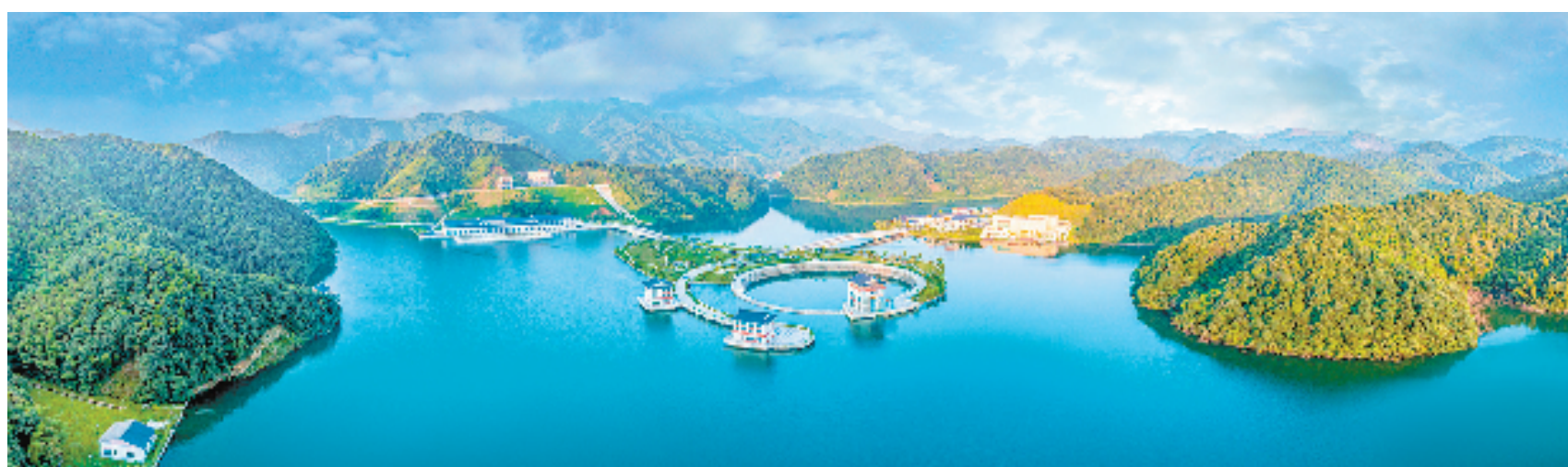
千岛湖配水工程
