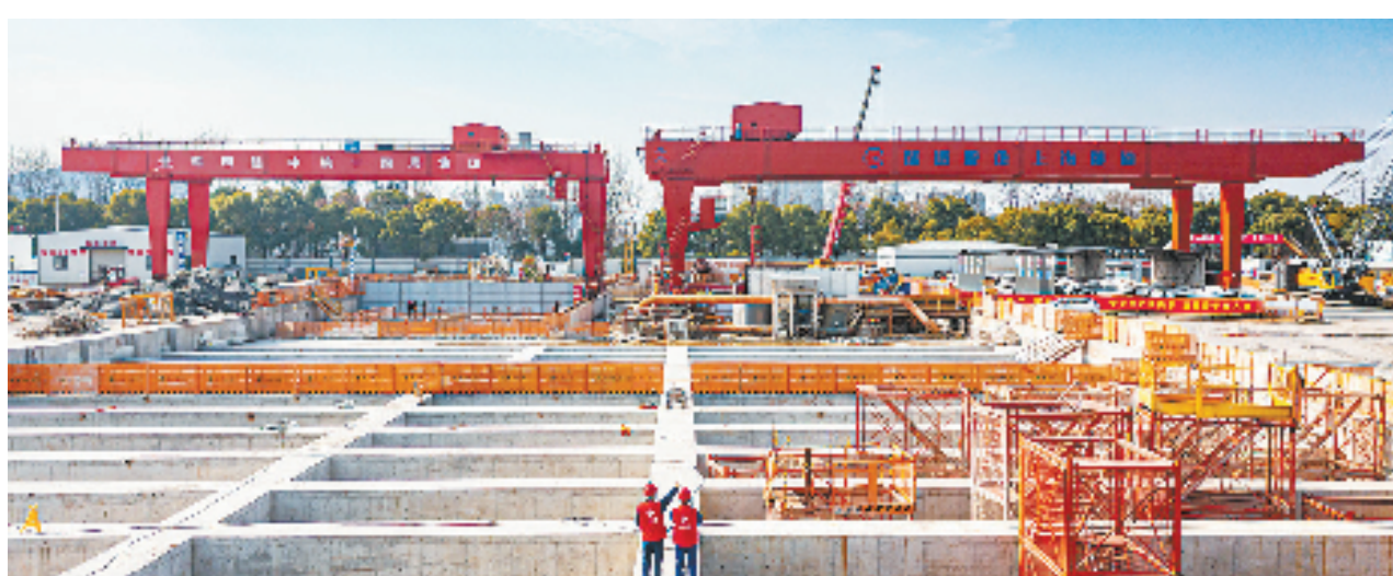
大有集团员工在富阳秦望隧道工程项目施工现场,勘察电缆敷设线路走向,形成合理、可实施的线路建设方案。 邵俊波 赵青艺 摄
