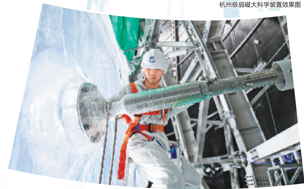
江门中微子实验探测器是位于地下700米的大科学装置，以测定中微子质量顺序、精确测量中微子混合参数为主要科学目标。图为工作人员在探测器内部的安装工作平台上调试设备。
